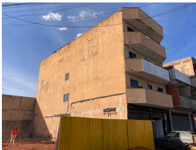
Fotografia 2 - Vista da fachada lateral.
