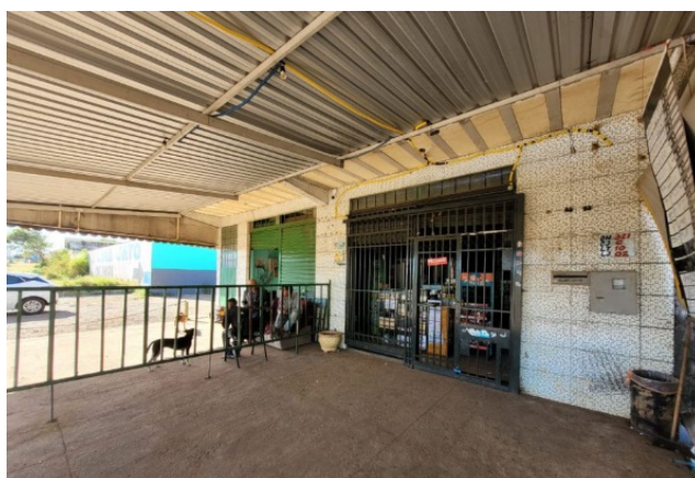
Fotografia 4 - Vista interna do imóvel
