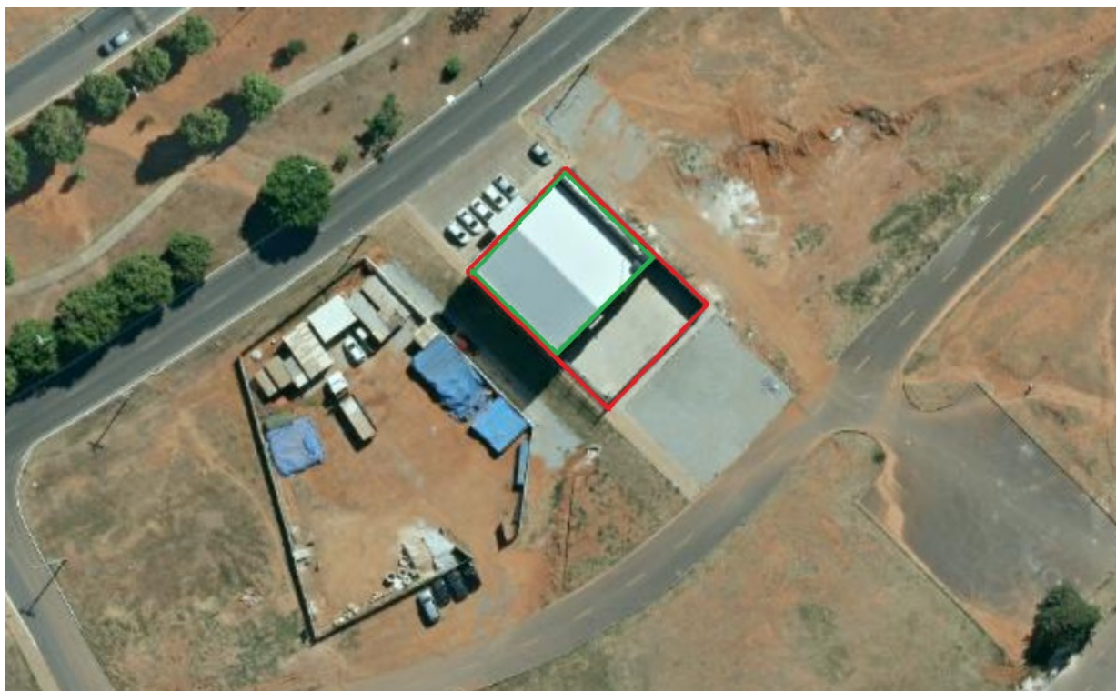
Imagem 1 - Imagem de satélite do imóvel com destaque do terreno e das benfeitorias.
