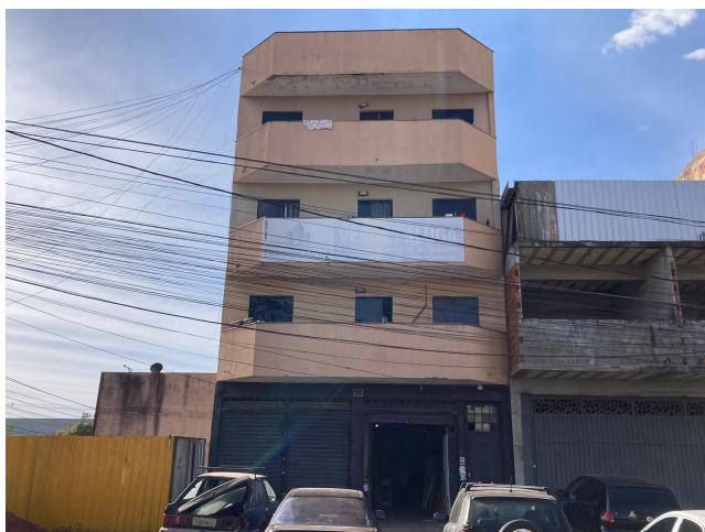
Fotografia 1 - Vista da fachada principal.
