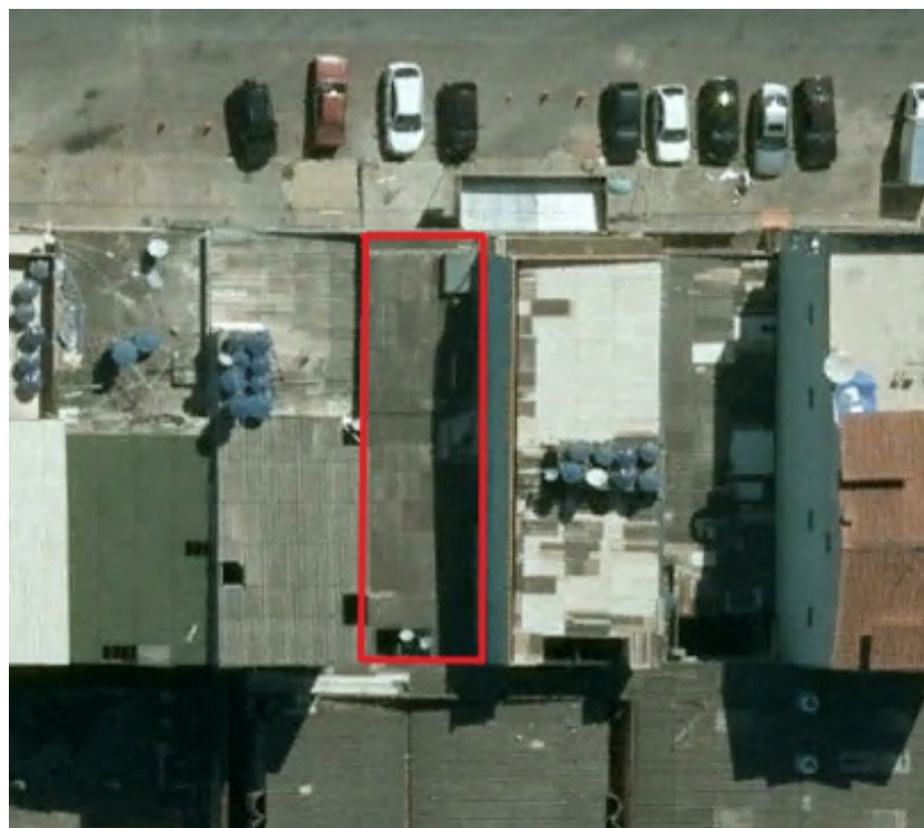
Imagem 1 - Imagem de satélite do imóvel com destaque das benfeitorias.
