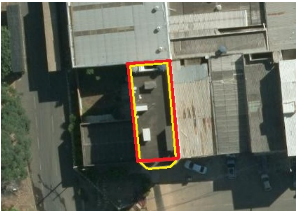
Imagem 1 - Imagem de satélite do imóvel com destaque das benfeitorias.
