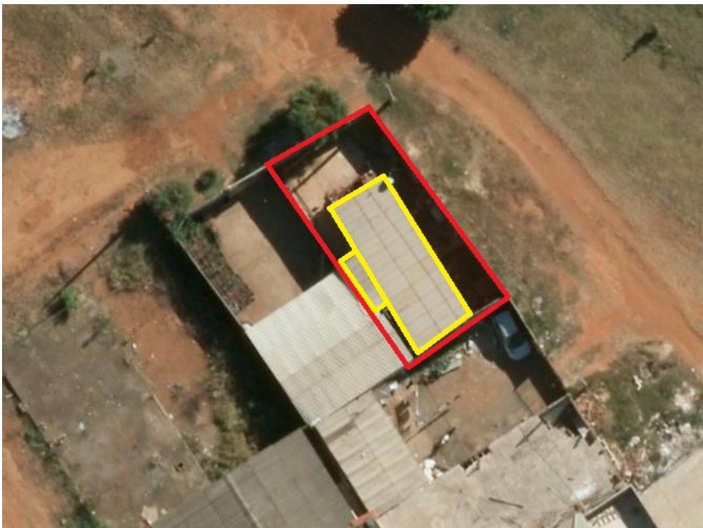
Imagem 1 - Imagem de satélite do imóvel com destaque das benfeitorias.
