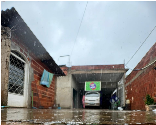
Fotografia 1 - Vista interna do lote
