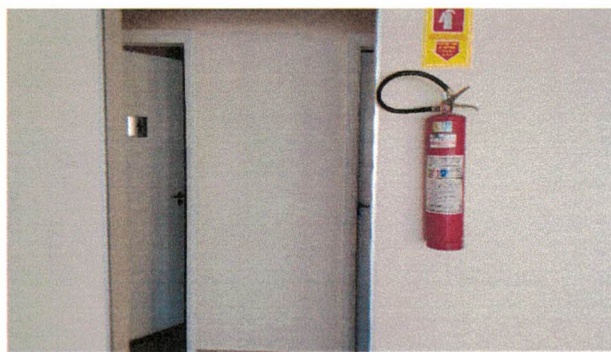
Banheiros Segundo Pavimento
